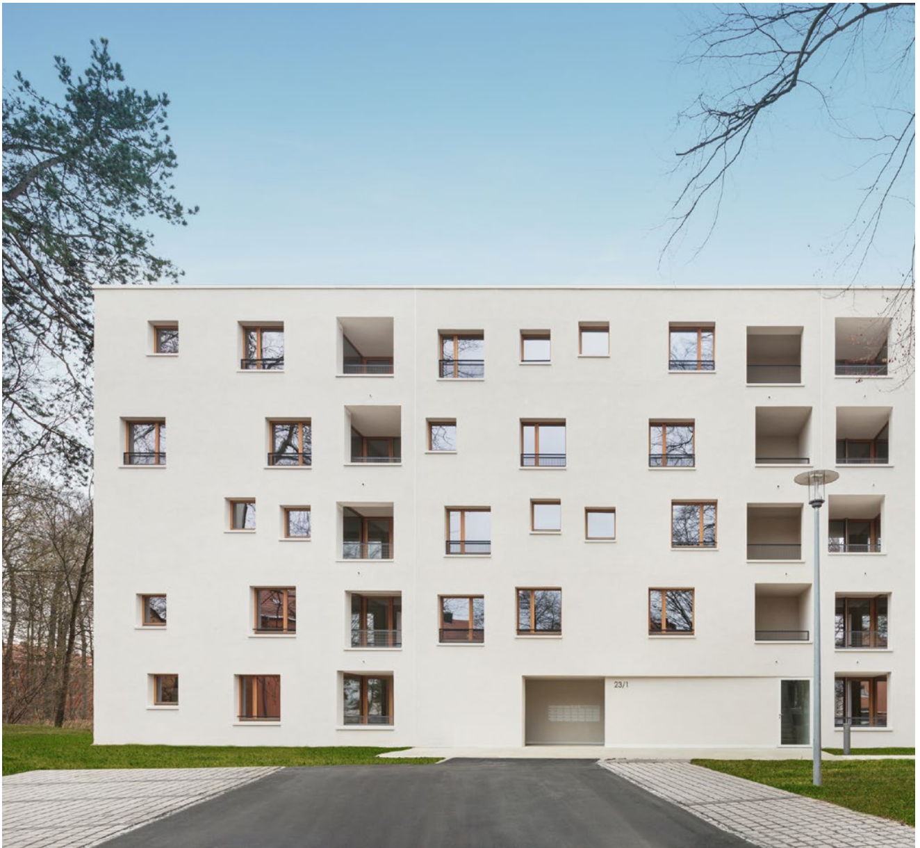
Ansicht von Nordosten mit Eingangsbereich
