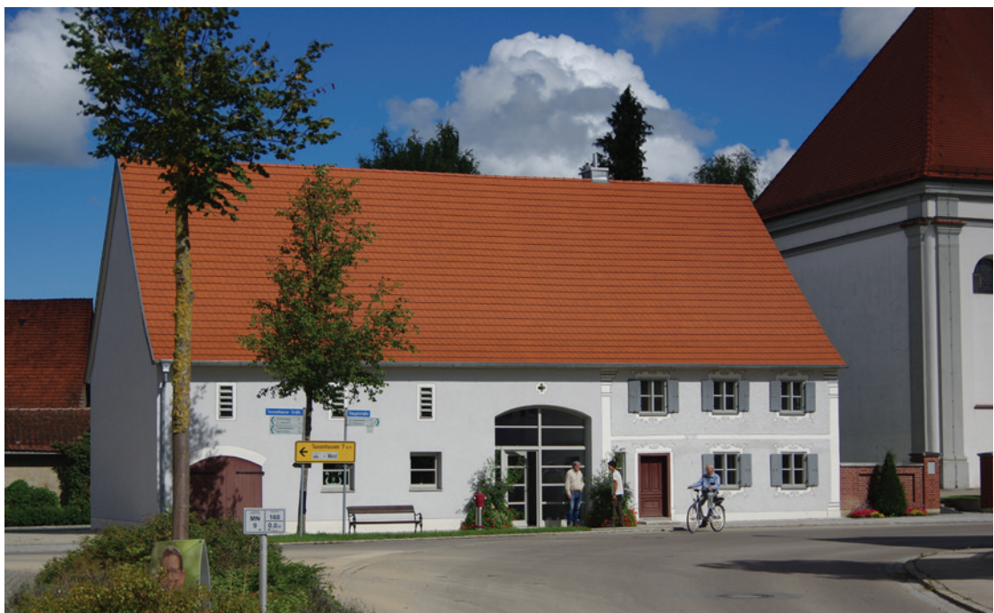
saniertes Mesnerhaus in der Ortsmitte Ettringens
