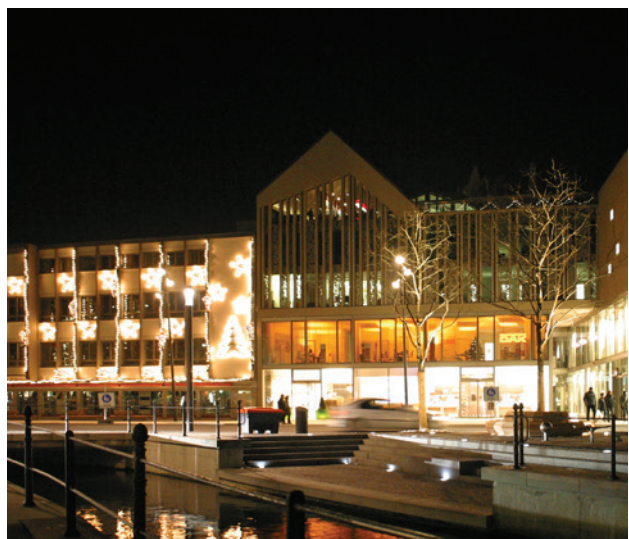
Abendstimmung am Schrankenplatz Memmingen mit freigelegtem Stadtbach und neuem Stadtbaustein
