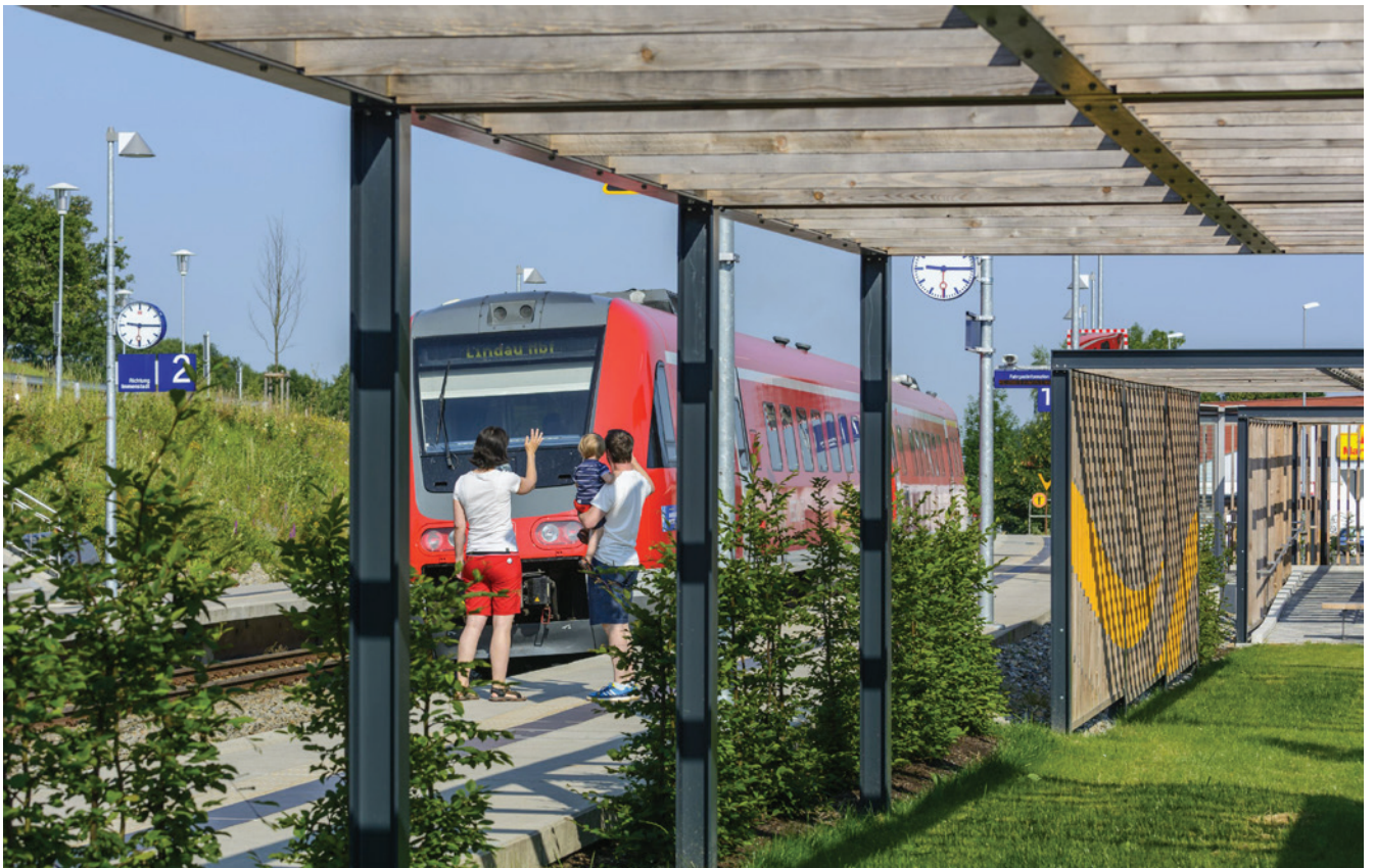
neuer Bahnhof Heimenkirch mit vorgelagerten Pergolen
