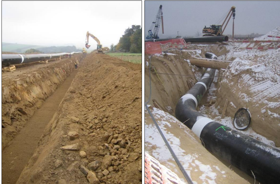
Abbildung 19: Erstellung des Rohrgrabens und Unterquerung von Fremdleitungen
