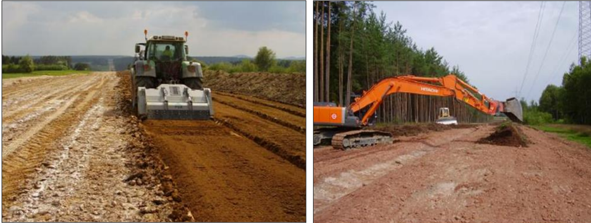
Abbildung 24: Rekultivierung: Schaffung eines Planums und Wiederauftrag des Oberbodens
