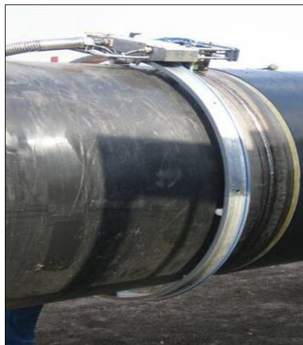
Abbildung 18: Prüfen der Schweißnähte mittels Ultraschall- / Durchstrahlungsprüfung
