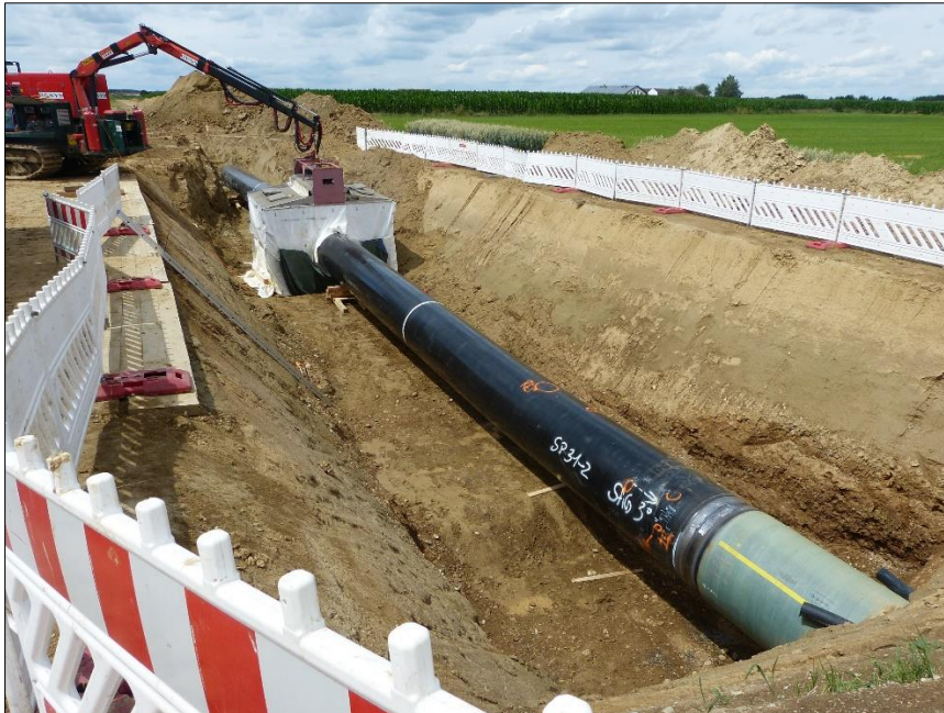
Abbildung 17: Verschweißen der Einzelrohre zum Rohrstrang
