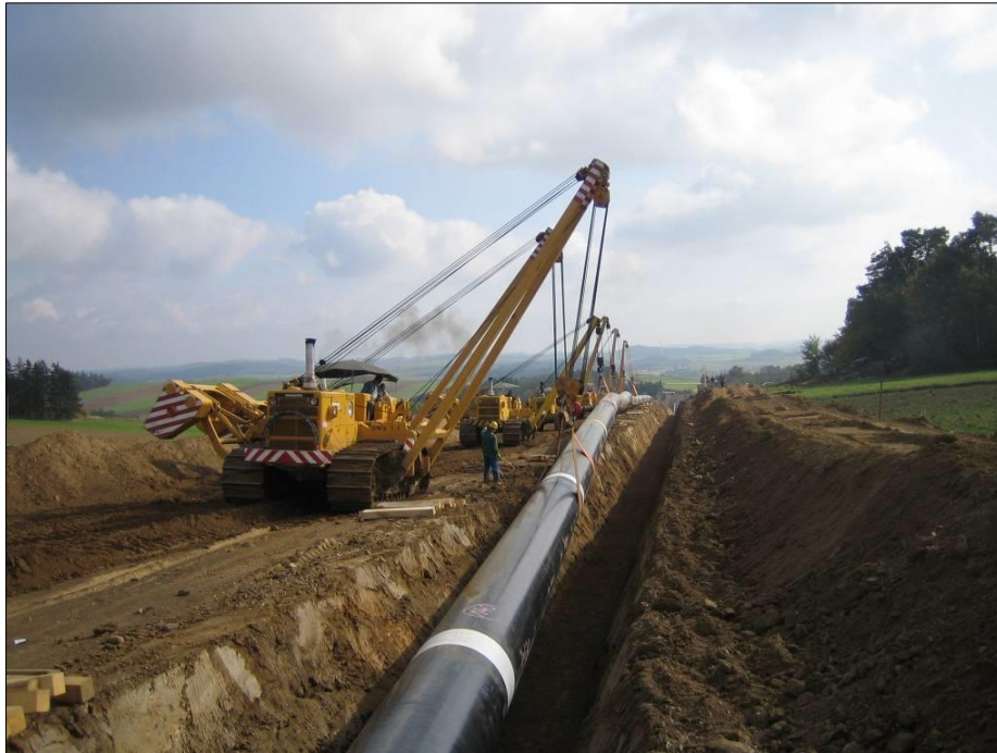
Abbildung 22: Absenken des Rohrstrangs mit Seitenbaumraupen
