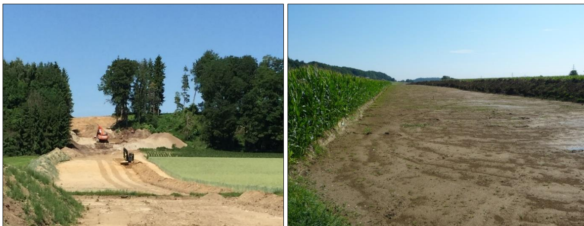
Abbildung 15: Trassenvorbereitung, Oberbodenabtrag
