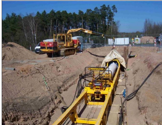
Abbildung 20: Horizontal-Bohr- / Pressverfahren
