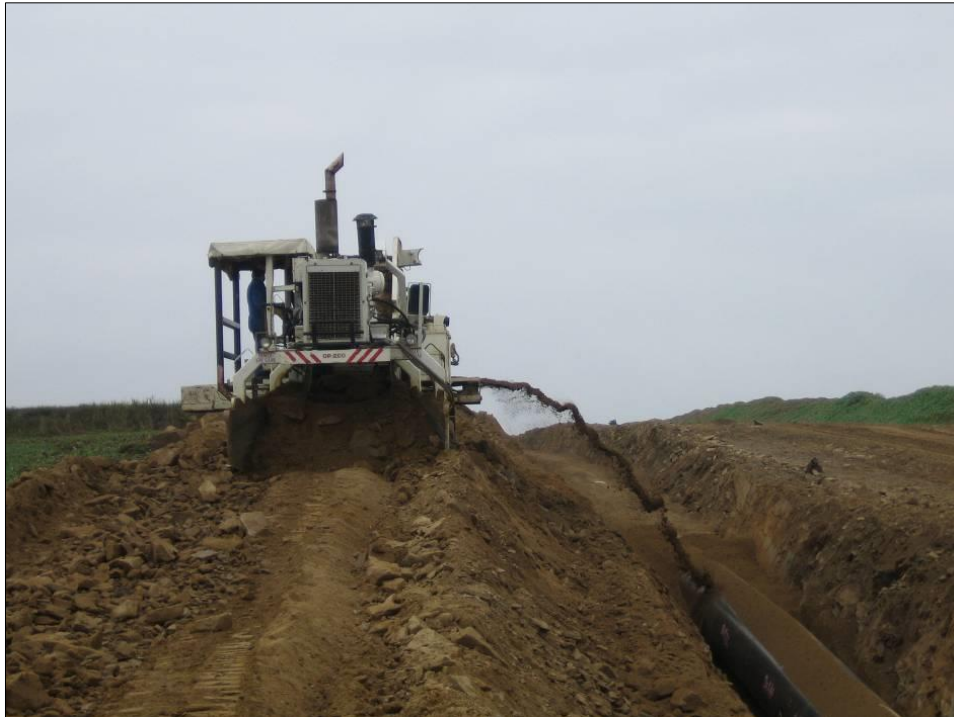
Abbildung 23: Verfüllen des Rohrgrabens
