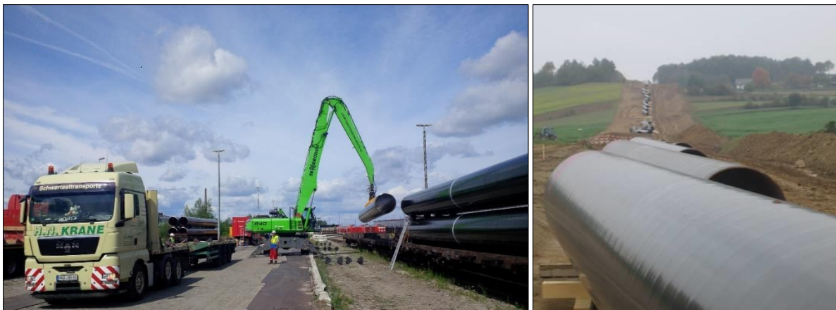
Abbildung 16: Verladen und Ausfahren der Rohre auf dem Arbeitsstreifen
