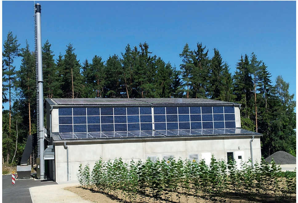
Das Heizkraftwerk von Bad Alexandersbad
