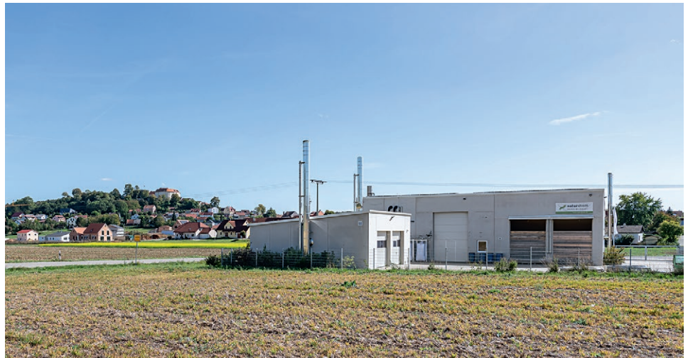
Die Heizzentrale vor der Burg Lupburg und dem Hauptort im Hintergrund
