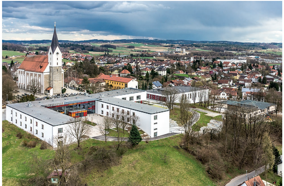
Schulgebäude der Mittelschule Hengersberg
