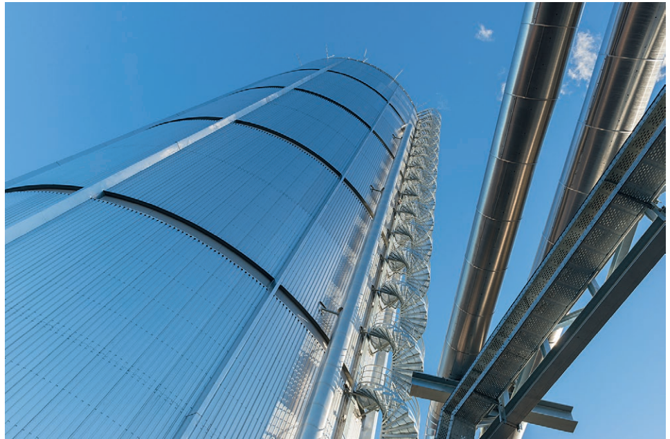
Der Wärmespeicher der N-ERGIE in Nürnberg-Sandreuth
