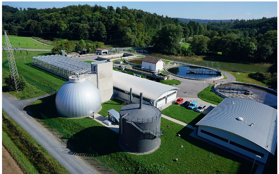
Gesamtansicht der Kläranlage
