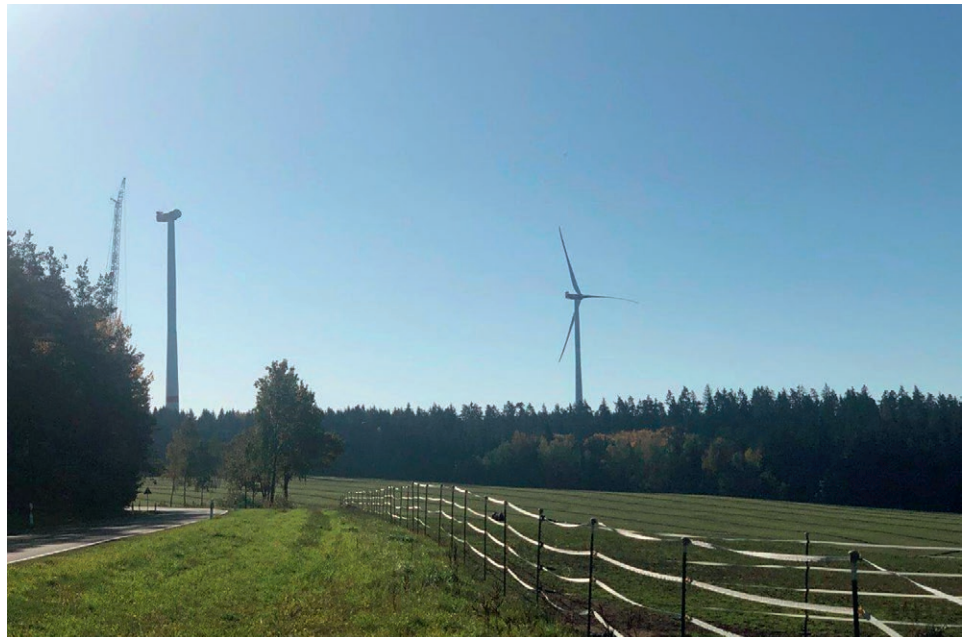
Die Windenergieanlagen in der Bauphase
