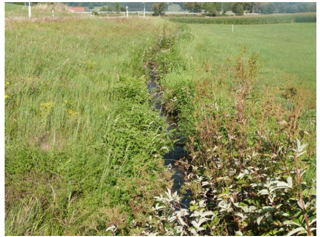
Abb.8: Haldenwanger Mühlbach, Kreisstraße OA19
