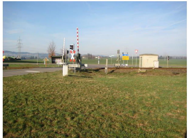
Abb. 4: Bahnübergang Nord bei Kassier, Blick auf OA19, Fläche CEF3 geplant
