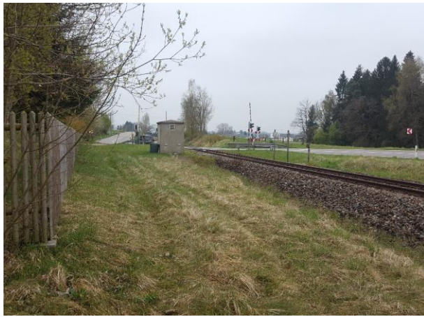
Abb.3: Kreisstraße OA 19, Bahnübergang bei Oberbühlers
