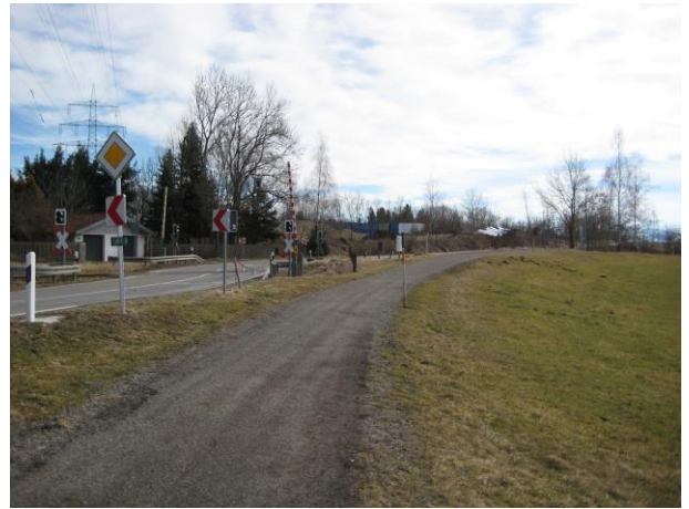
Abb.2: Kreisstraße OA 19, Bahnübergang Süd, Geh- und Radweg
