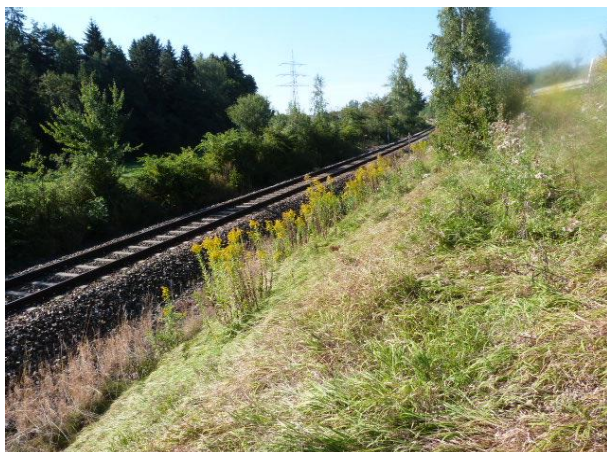
Abb. 5: Bahnstrecke, Bahnböschungen (Habitat Zau-neidechse, Insekten) links Biotop Feuchtwald
