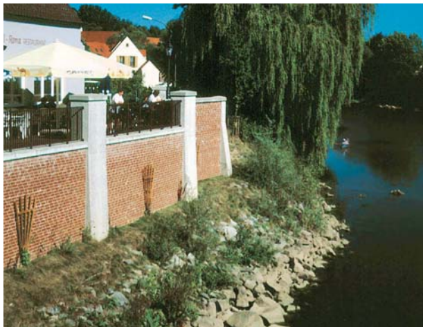
Hochwasserschutz durch Mauern...
