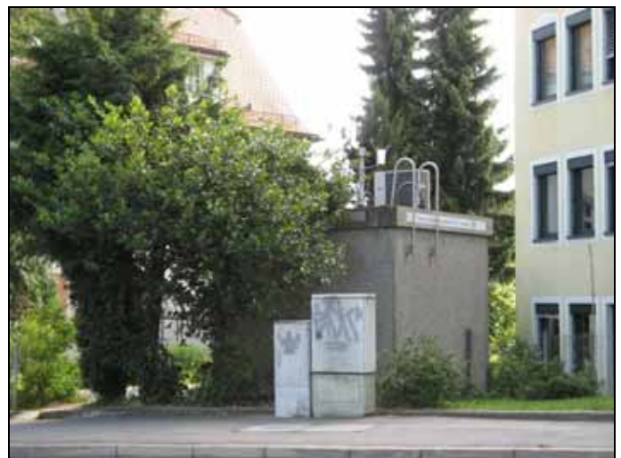
Abbildung 5: LÜB Station - Ansicht
